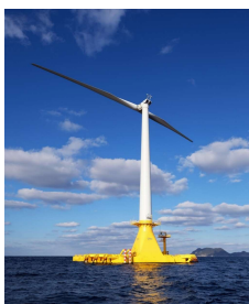
バージ型浮体風車 3MW, 北九州沖 2019年
