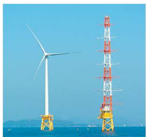
ジャケット式着床 2MW, 北九州沖 2013年
