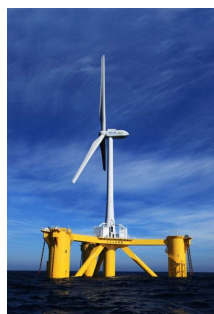
セミサブ 2MW ダウンウインド風車 2013年
