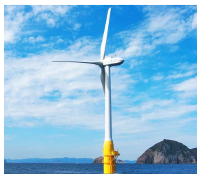
100kW, 2012年 実証機 2MW, 2013年 ダウンウインド風車, ハイブリッドスパー浮体 五島沖
