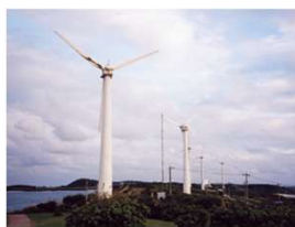
250kW×2, 400kW×3 宮古島西平安名崎 NEDO/沖縄電力 1993年
