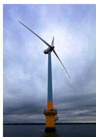
重力式着床 2.4MW, 銚子沖 2013年
