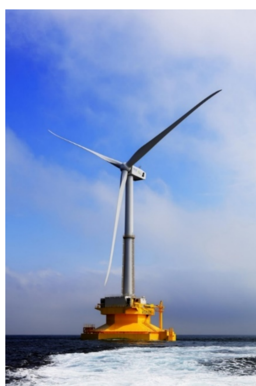
5 MW Down Wind風車 アドバンスドスパー 2016年
