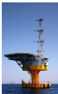
洋上変電所 2013年
