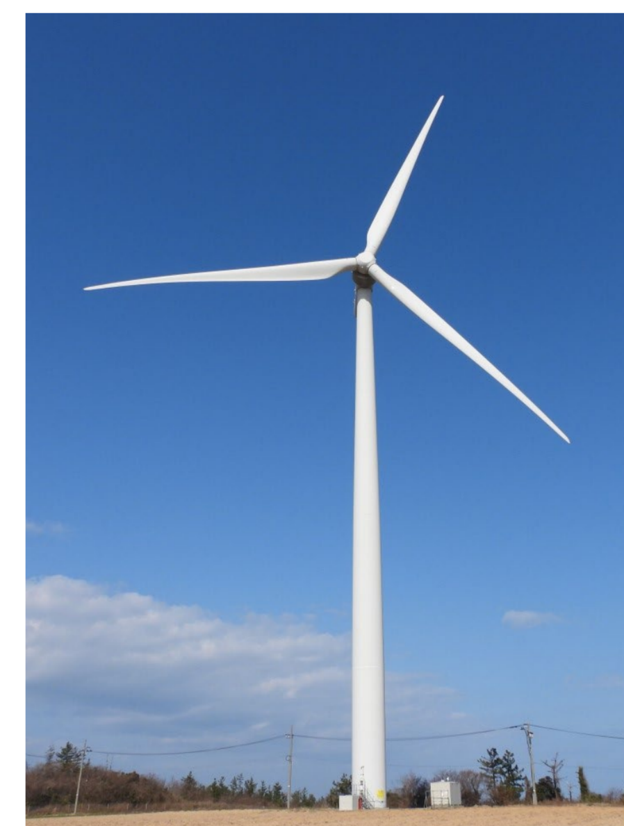
日本製鋼所 2MW
