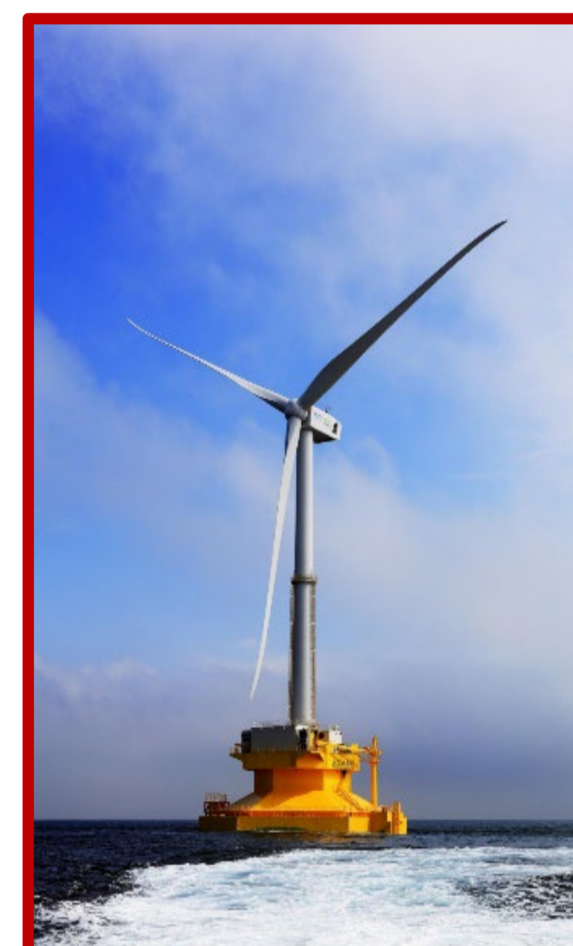
5MW Downwind 量産 浮体式(福島)
