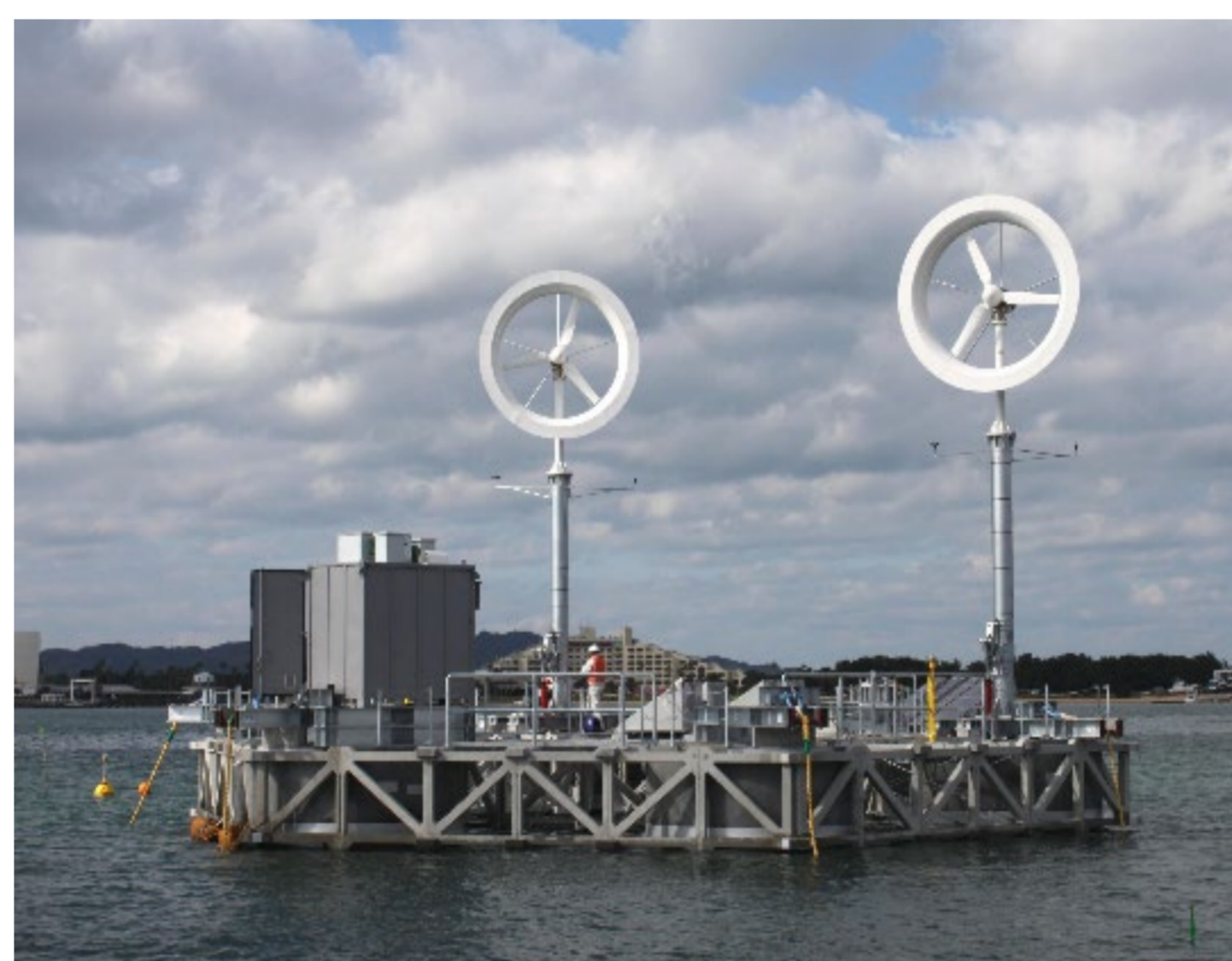
九州大学 浮体式風レンズ風車 3kW×2, 2011年
