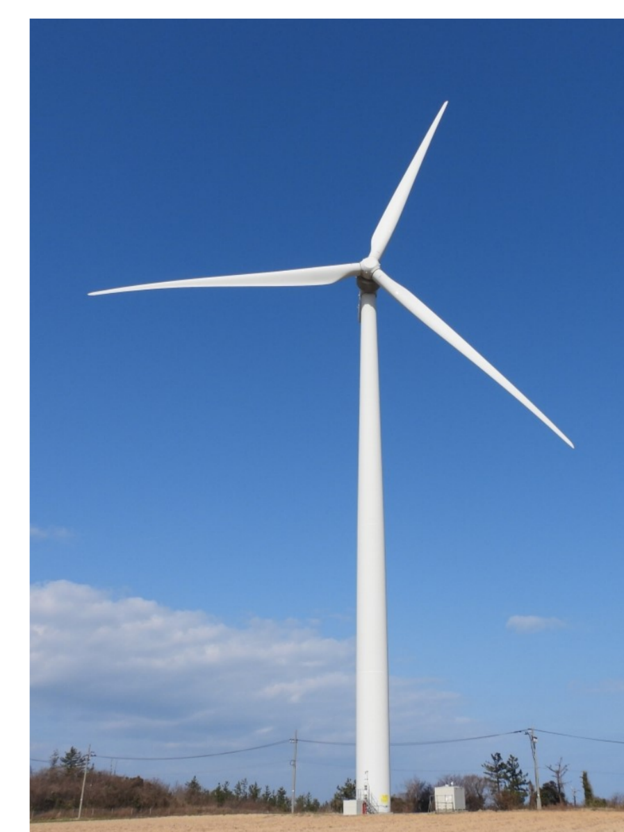
日本製鋼所 2MW
