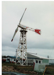
第2次風トピア計画, 水素貯蔵システム, 20kW 秋田県大湯村, 1982年
