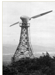
ダウンウインド型揚水風車 45kW, 岩手県衣川村, 1986年
