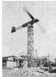
電電公社, 水平軸風車, 直径8m, 2 kW, 伊豆大島, 1977年
