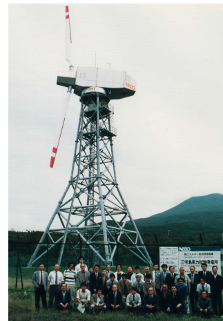
NEDOサンシャイン計画 石川島播磨重工 二枚翼ダウンウインド風車 100kW, 三宅島, 1983年
