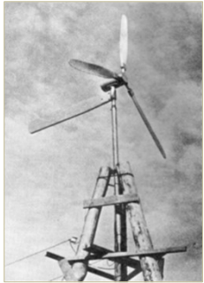
山田式風車, 3枚翼可変ピッチ山田基博開発, 600W, 1977年
