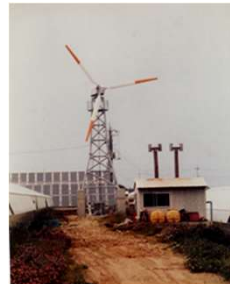
温室加温風車, 山田風車, 15 kW, 鳥取大学, 1985年
