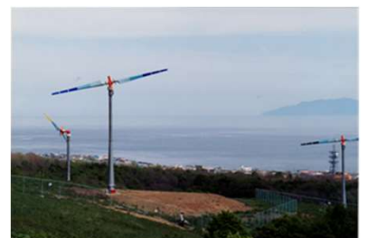
日本初のウィンドファーム, 82.5kW ヤマハ 16.5kW×5, 北海道寿都町, 1989年
